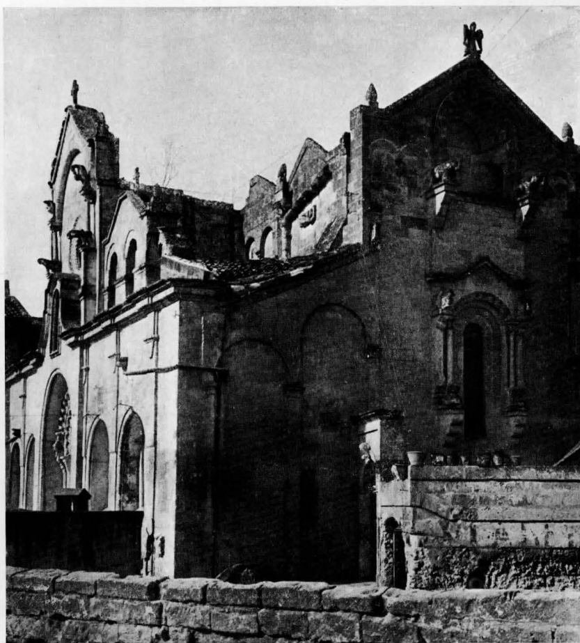
FIG. II - MATERA, CHIESA DI S. GIOVANNI BATTISTA - VEDUTA ANGOLORE DEL PROSPETTO ABSIDALE PRIMA DELL'ISOLAMENTO (Fot. Soprint. Bari)
