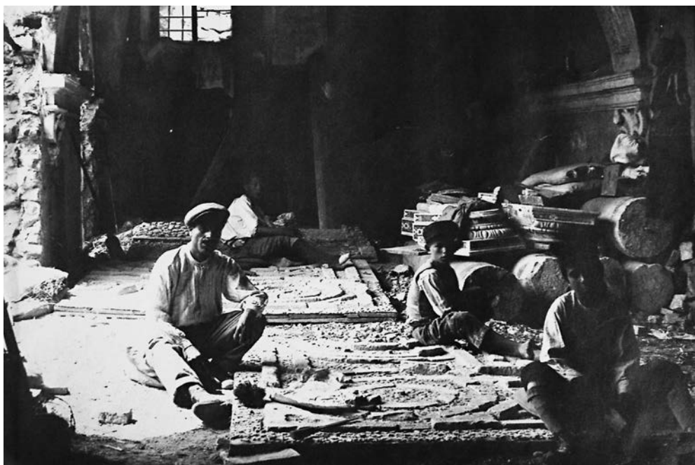
FIG. 16. Fase di rimozione del sottofondo del pavimento nel corso della sua 'disfittura', 1917 (Archivio della Soprintendenza per i Beni Archeologici della Calabria).
