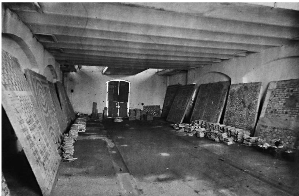
FIG. 18. I pannelli distaccati dopo la rimozione della tela di protezione dalla faccia esterna (Archivio della Soprintendenza per i Beni Archeologici della Calabria).
