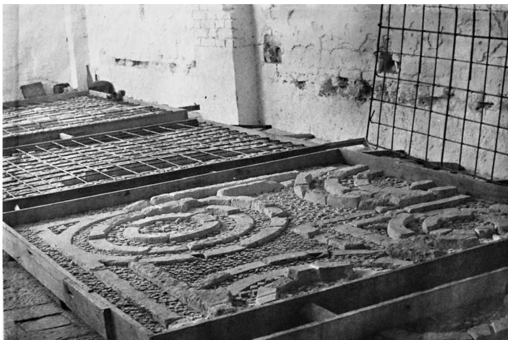
FIG. 17. I pannelli prima della realizzazione del nuovo massetto in calcestruzzo armato con rete metallica, 1917 (Archivio della Soprintendenza per i Beni Archeologici della Calabria).
