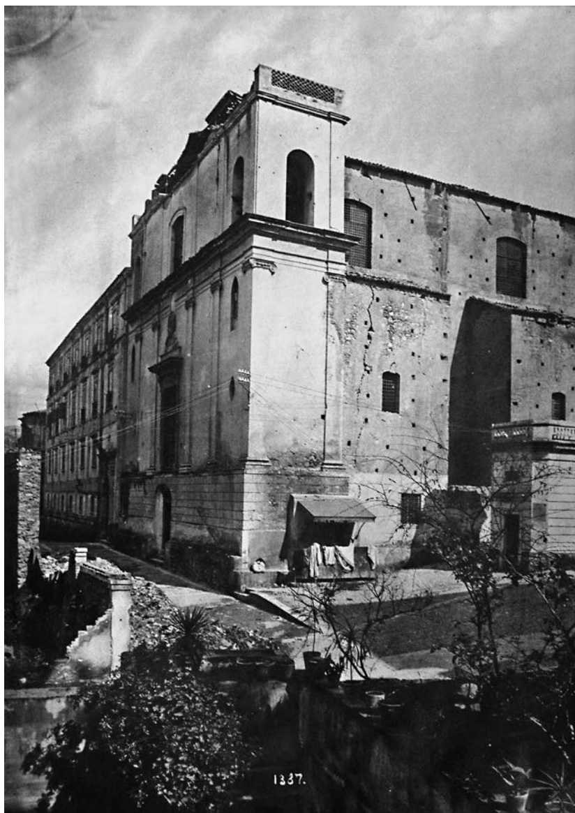
FIG. 15. Lo spigolo sud-est della chiesa di San Gregorio Magno, ante 1908. Si noti, al piano terra, l'ingresso alla sottostante chiesa che risultava edificata in parte controterra (Archivio della Soprintendenza per i Beni Archeologici della Calabria).
