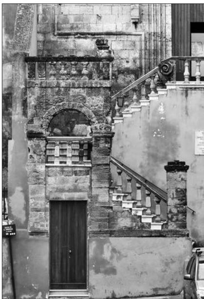
Fig. 5. - S. Domenico. Particolare della scalinata da cui si coglie l'imposta di uno degli archi demoliti.
