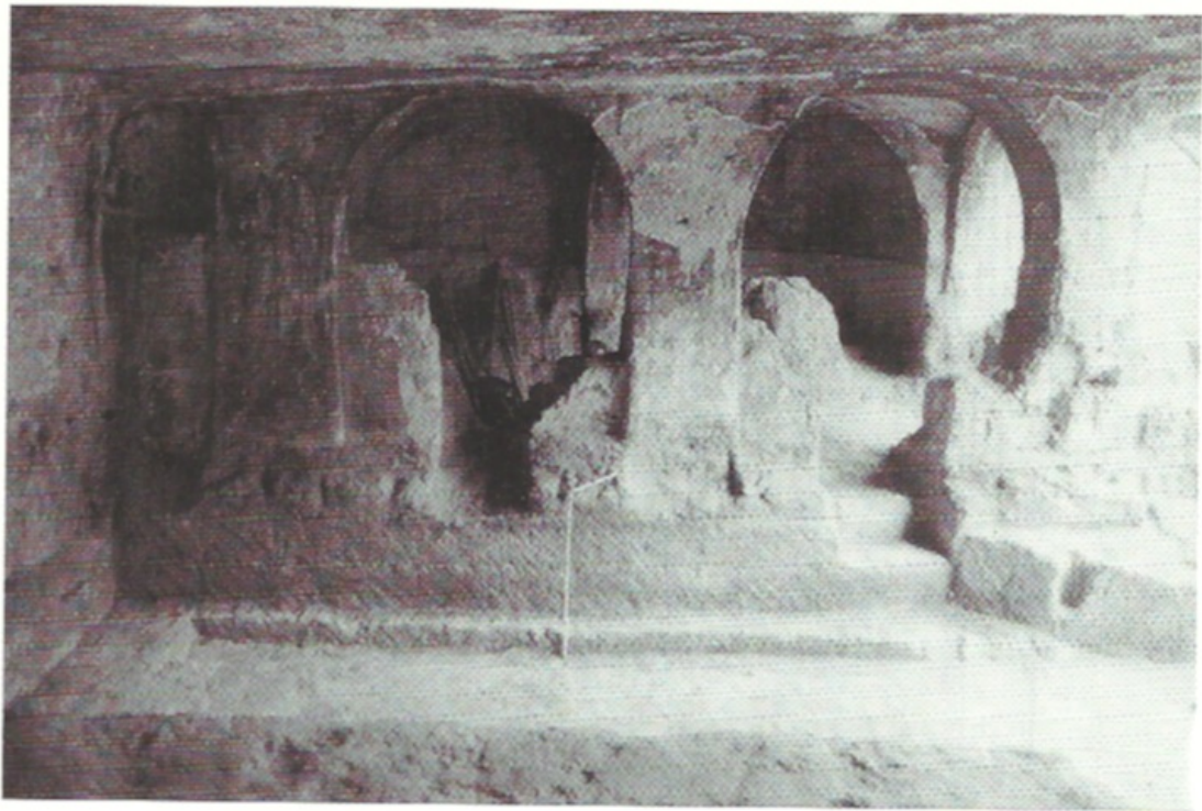
Figura 45 (M.S.). Interno del San Leonardo con in evidenza l'abbassamento del piano di calpestio documentato nei disegni delle sezioni a Figg. 8-9.
